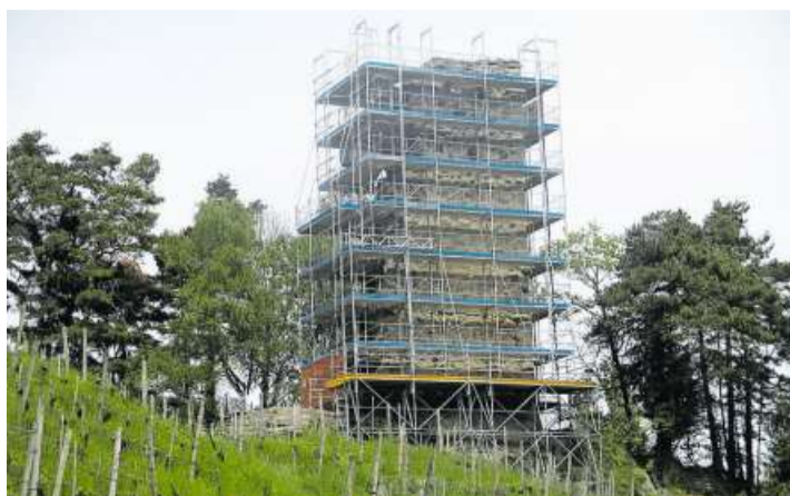
In den kommenden Monaten wird die zwischen St. Margrethen und Walzenhausen gelegene Burgruine Grimmenstein umfassend saniert.
